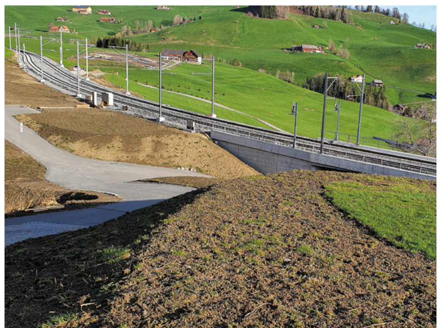
Die neue Kreuzungsstelle Schopfhalde steht vor ihrer Fertigstellung.
